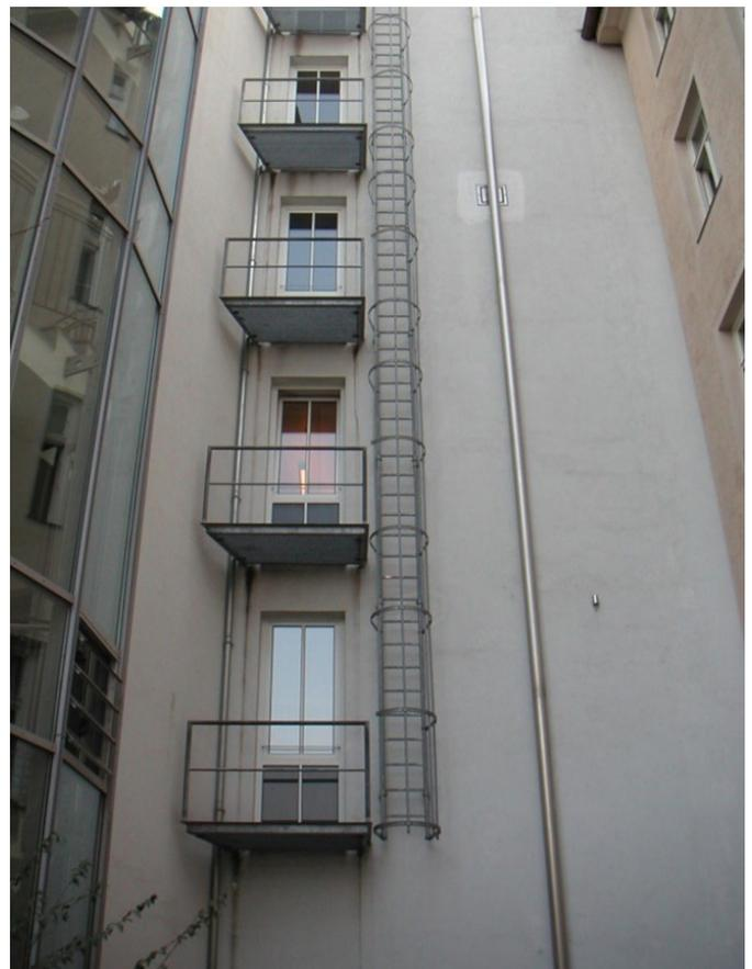
Foto 2: Fehlerhafte Notleiteranlage ohne gesichertes Leiterende; diese stellt eine Gefahr für die Gebäudenutzer und die Einsatzkräfte dar (baulicher Mangel)
